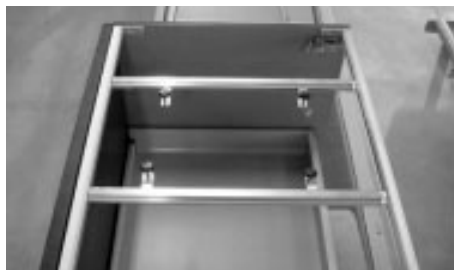
Regolare i piolini fino all'appoggio del lavabo.
